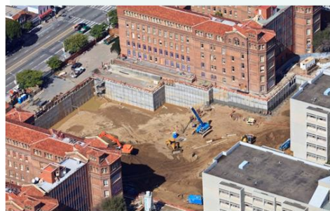
Las cuadrillas de trabajadores excavan un hoyo de hasta 45 pies de profundidad para los cimientos.
